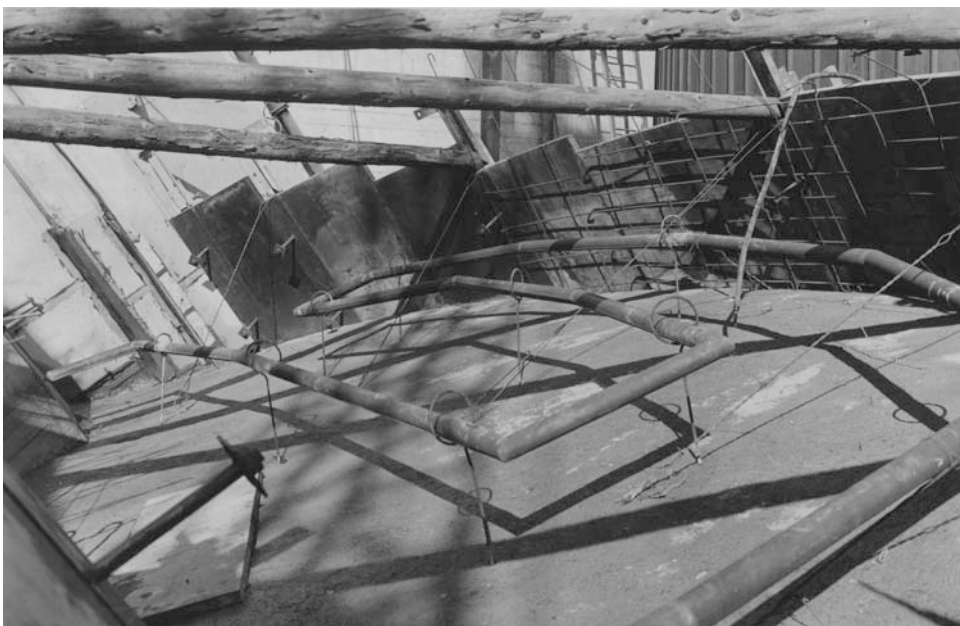
Abb. 7: Kühlschlange im Rundkopf
