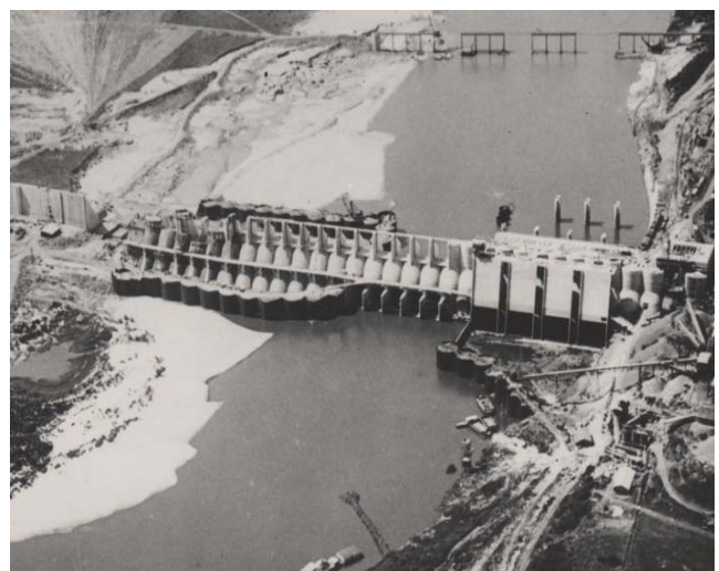
Abb. 2: Staudamm von Oberwasser aus gesehen 1941
